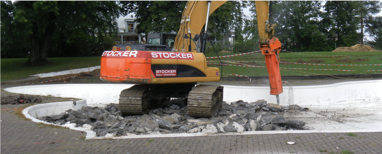
Abbruch des Kinderbeckens (Bild: FRIEDLIPARTNER AG)
