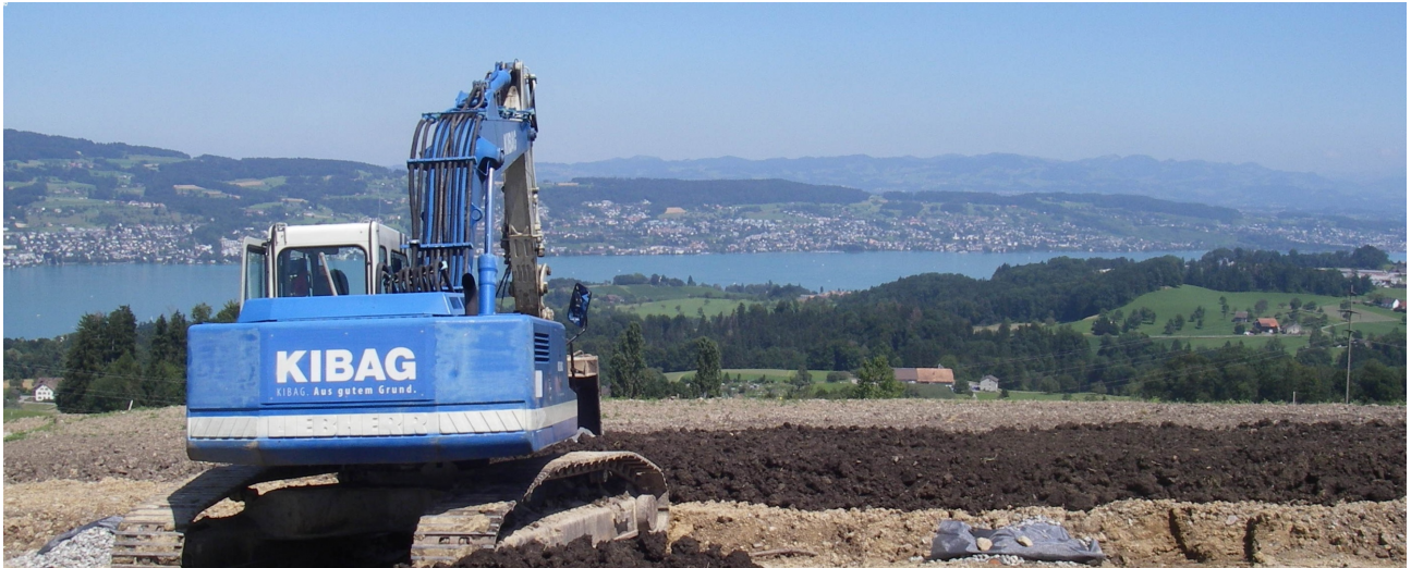
Auftrag Oberboden und Bodenaufbau: Drainageschicht, Unter- und Oberboden (Bild: FRIEDLIPARTNER AG)
