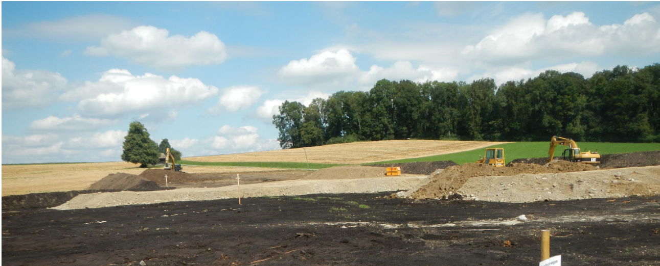
Bodenauftrag Etappe 1 (Bild: FRIEDLIPARTNER AG)
