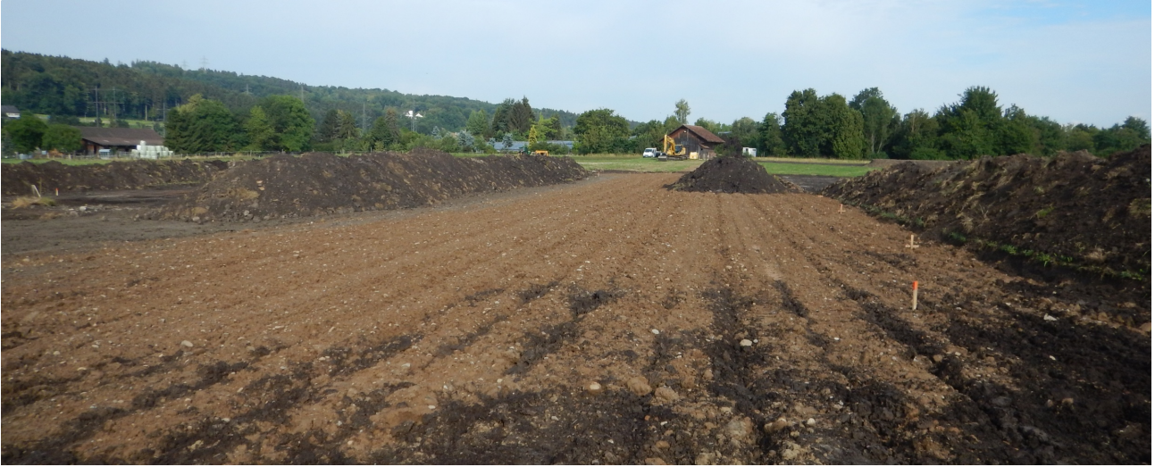
Bodenauftrag Etappe 1 (Bild: FRIEDLIPARTNER AG)
