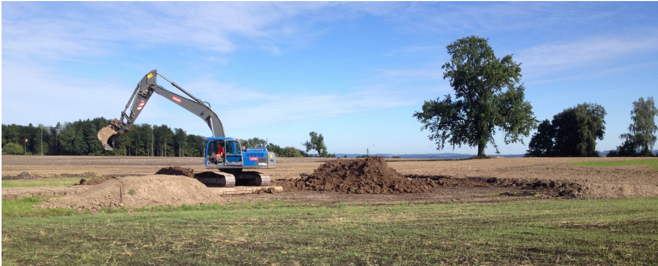
Bodenauftrag Etappe 1 (Bild: FRIEDLIPARTNER AG)
