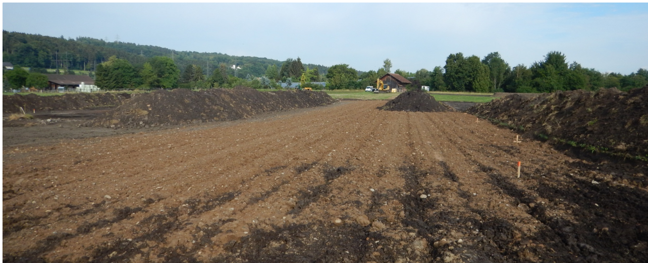
Bodenauftrag Etappe 1 (Bild: FRIEDLIPARTNER AG)
